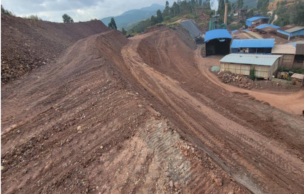
图2-5 采场堆积边坡现状图
