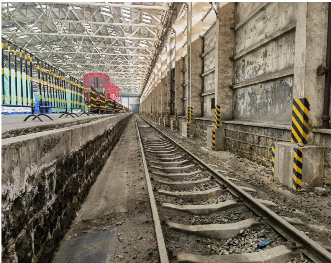
图 2-5 氢氧化钠（非罐装）到达作业线（11 道）现场
