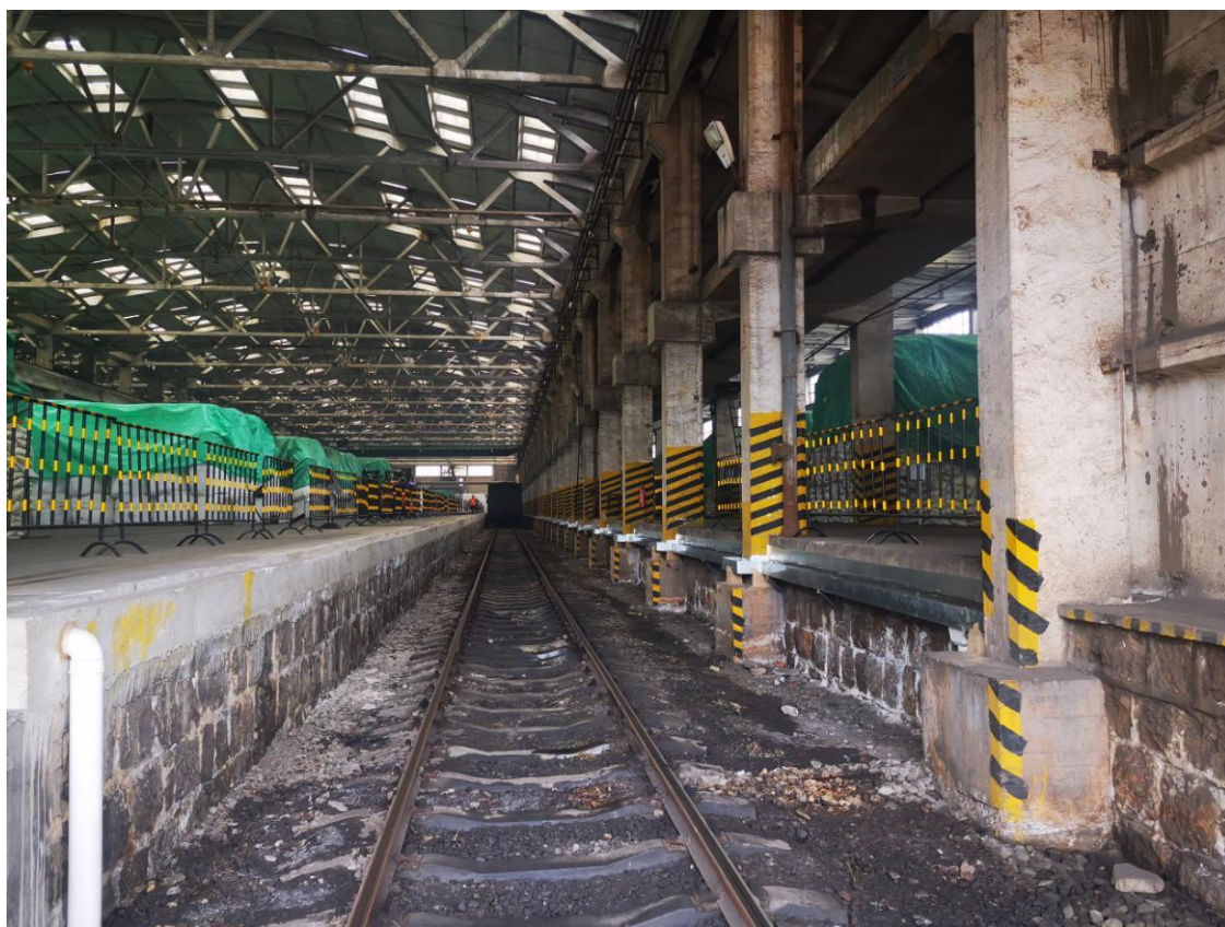
图 2-6 硫磺（非罐装）到达作业线（12 道）现场
