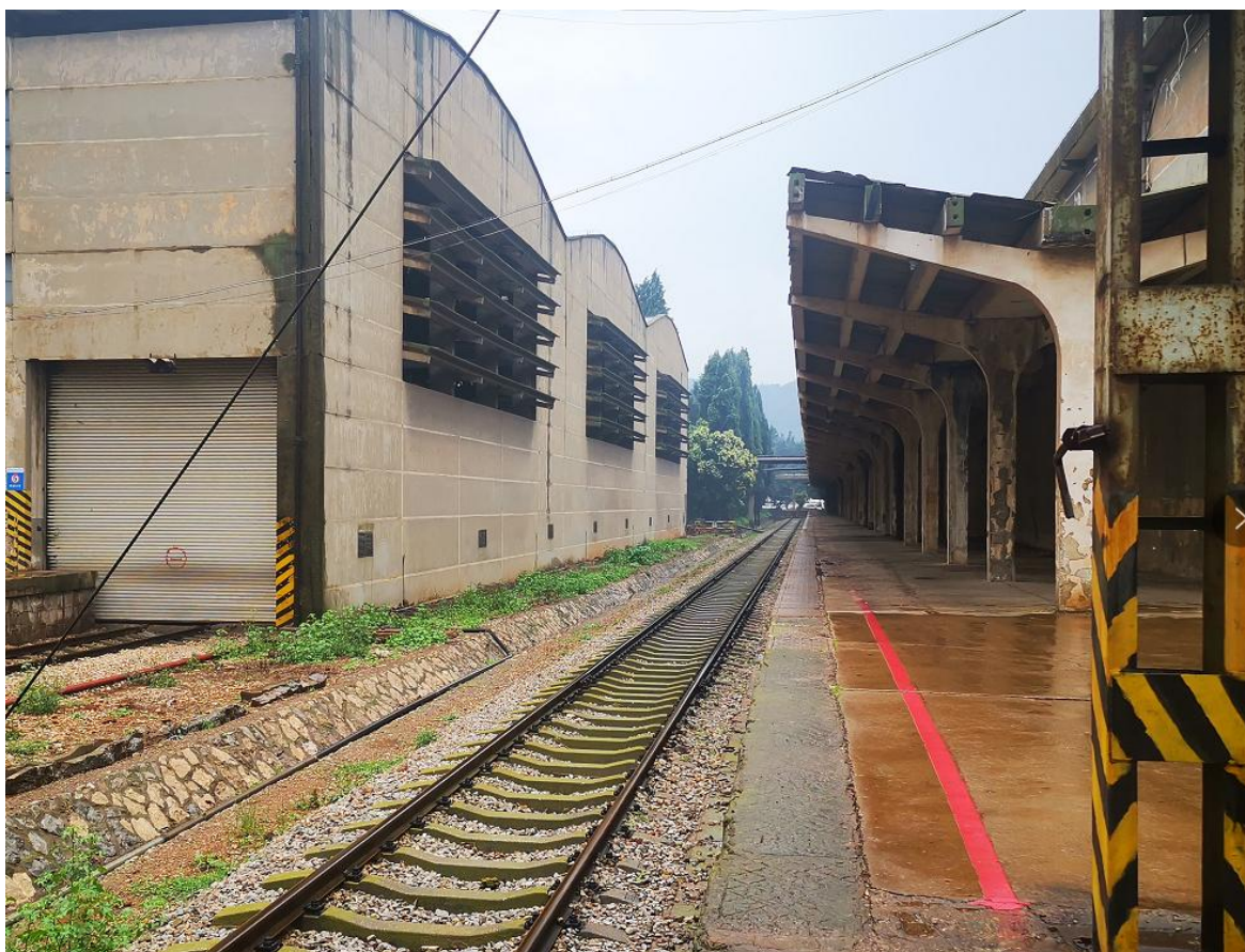
图2-3 磷酸（非罐装）发送作业线现场
